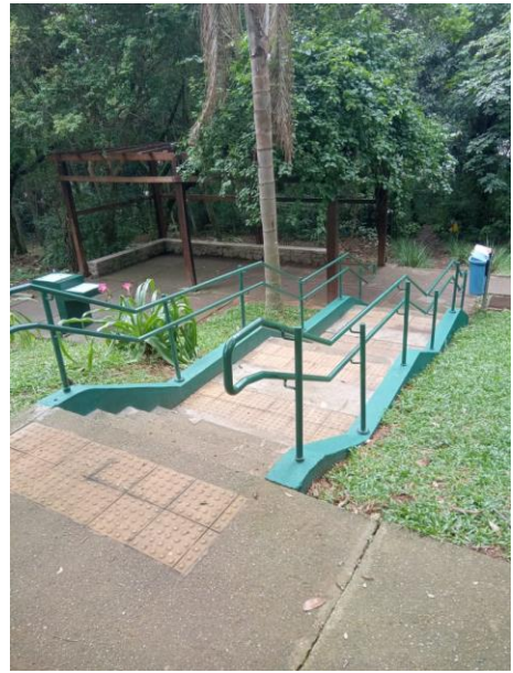
Figura 34: Pintura do corrimão
