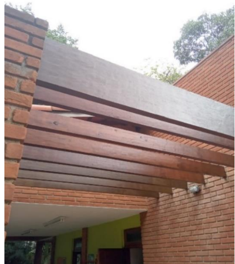
Figura 36: Manutenção e pintura pergolados
